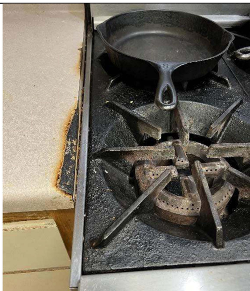
Daños en la vieja cocina/encimera
