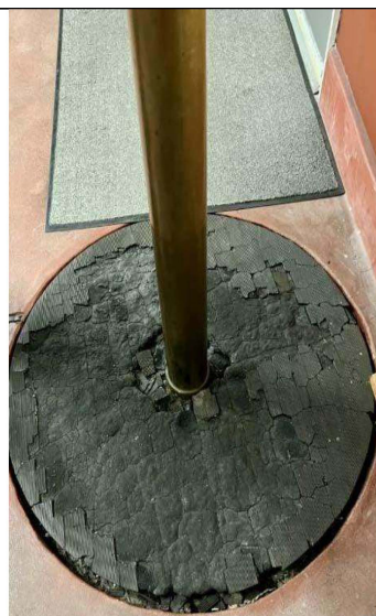
Mal estado de la pista de aterrizaje del poste de bomberos
