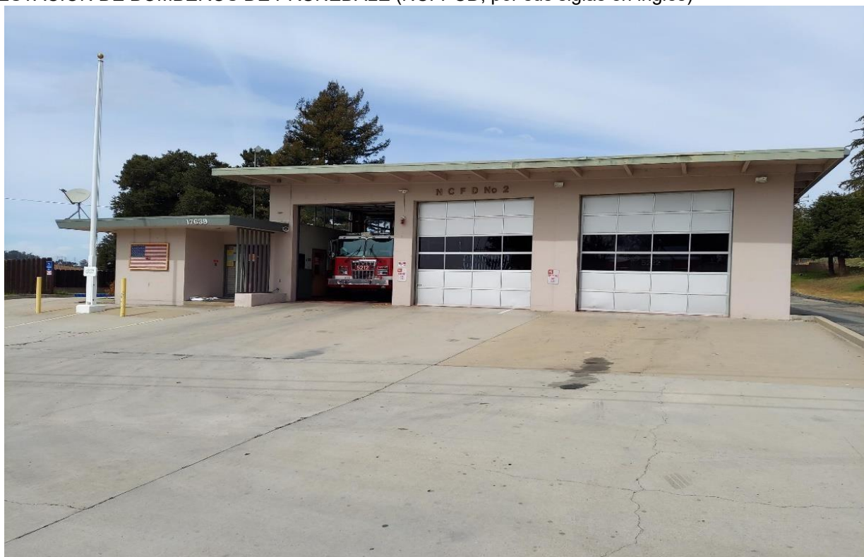
ESTACIÓN DE BOMBEROS DE PRUNEDALE (NCFPCD, por sus siglas en inglés)
