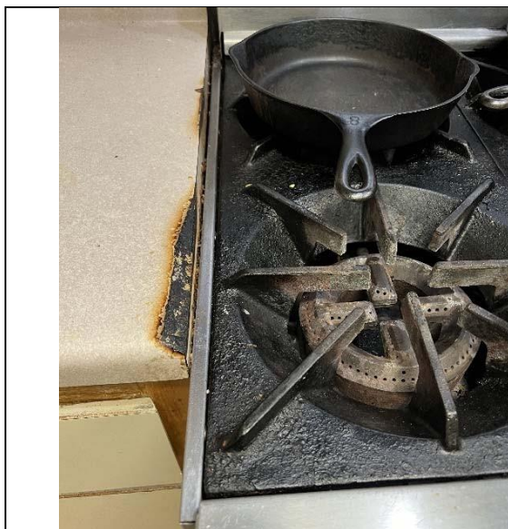
Daños en la vieja cocina/encimera
