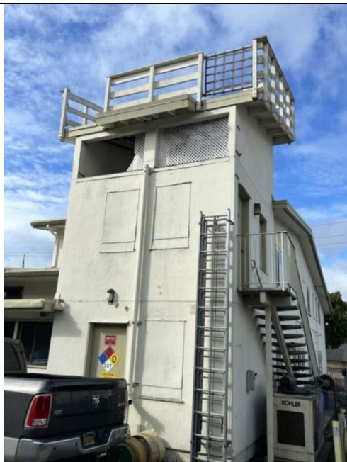
Torre de entrenamiento abandonada
